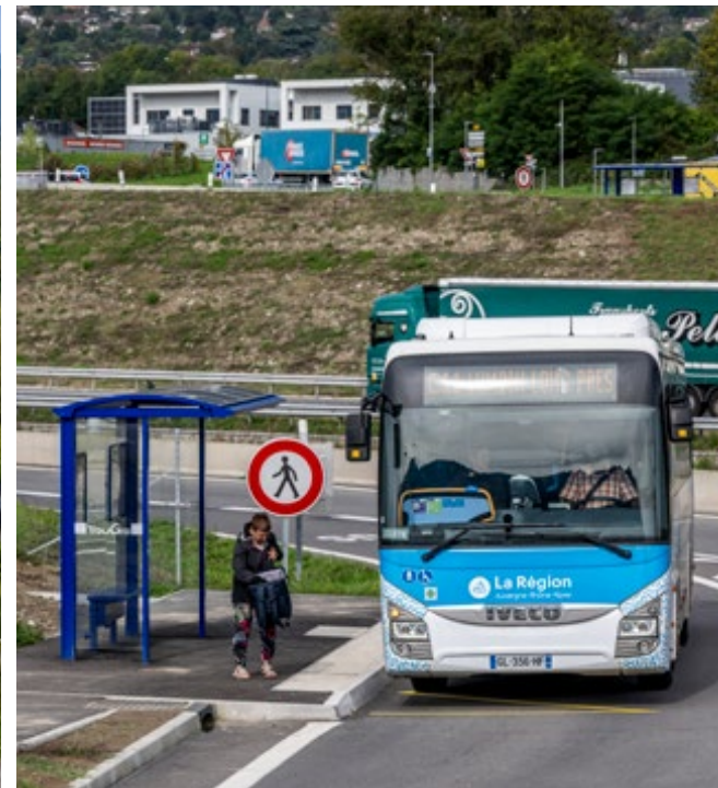
PÔLE D'ÉCHANGES MULTIMODAL DE LA BÂTIE dans le secteur de Grenoble sur l'A41 Sud mis en service en octobre 2024
